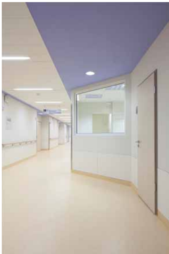
Flur: SD-Place mit F90-Vergrasung / Nebenräume
