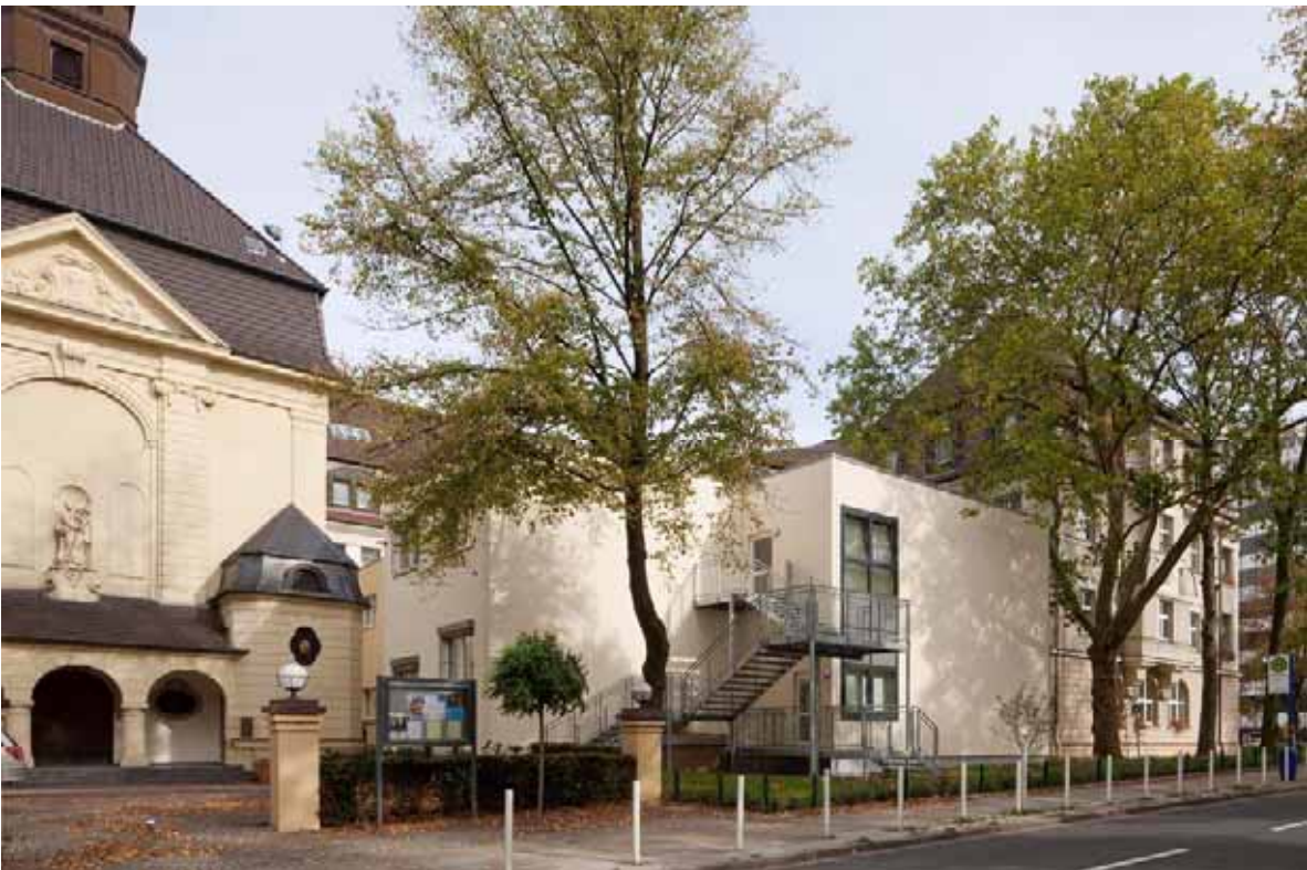
Die Interimsstation im Zusammenspiel mit den Bestandsgebäuden
